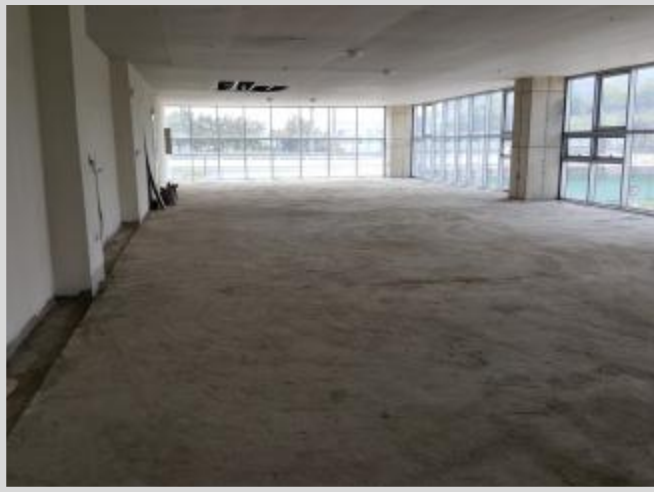
기호(32) 2층 236호 부대시설 내부 전경 2
