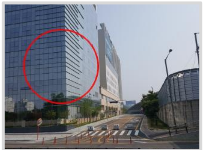
본 건 및 남동측 후면 도로변 전경
