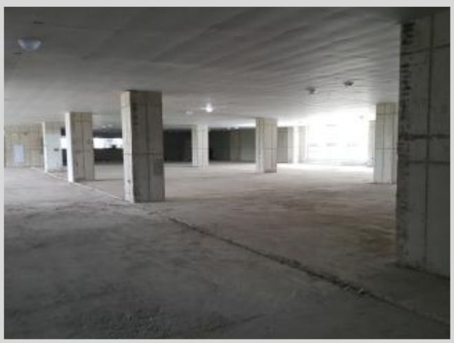
기호(31) 2층 234호 부대시설 내부 전경 3
