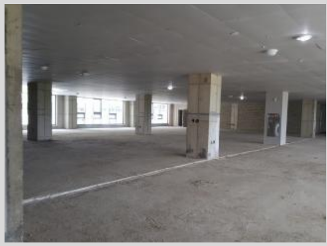
기호(31) 2층 234호 부대시설 내부 전경 1
