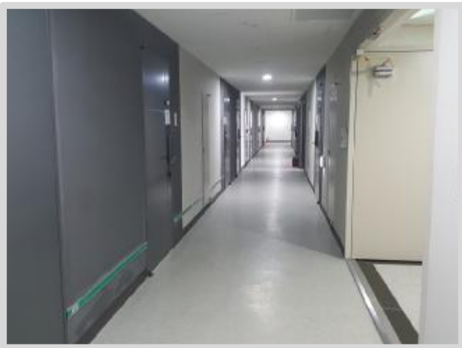
지웰오피스텔 내부 복도 등 전경 1
