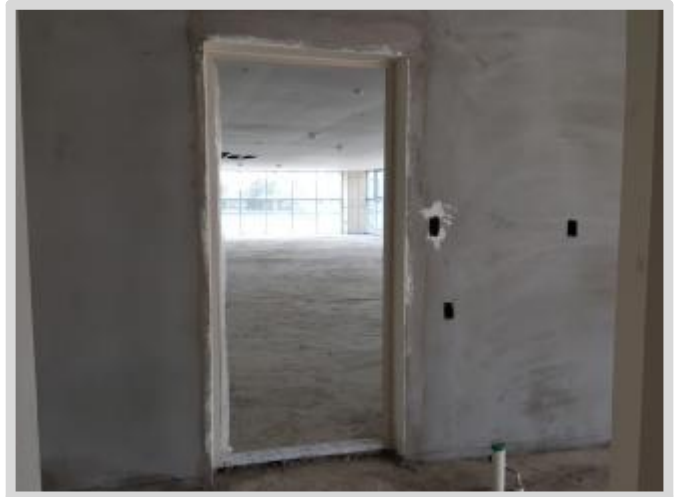
기호(32) 2층 236호 부대시설 내부 전경 1
