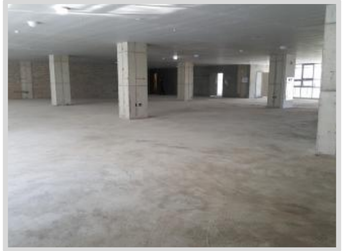
기호(31) 2층 234호 부대시설 내부 전경 2
