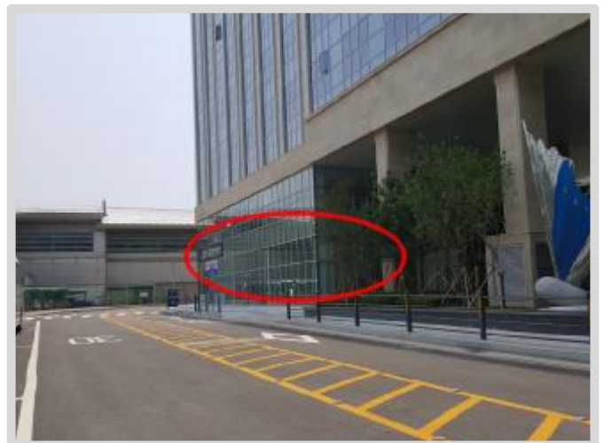
기호(20,21) 등 1층 북동측 전면 근린생활시설 전경 2
