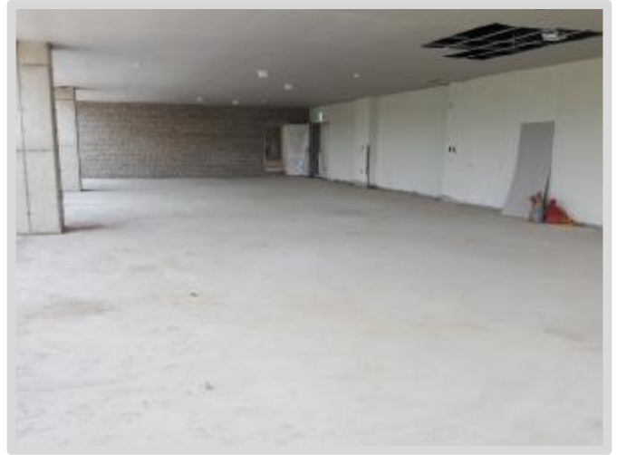
기호(32) 2층 236호 부대시설 내부 전경 3
