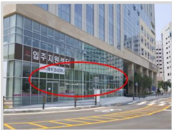
기호(20,21) 등 1층 북동측 전면 근린생활시설 전경 1
